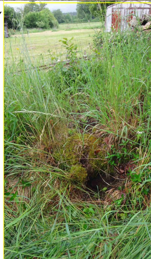
Zone de tassement des remblais au droit de l'ancien puits, sur le talus bordant le chemin
