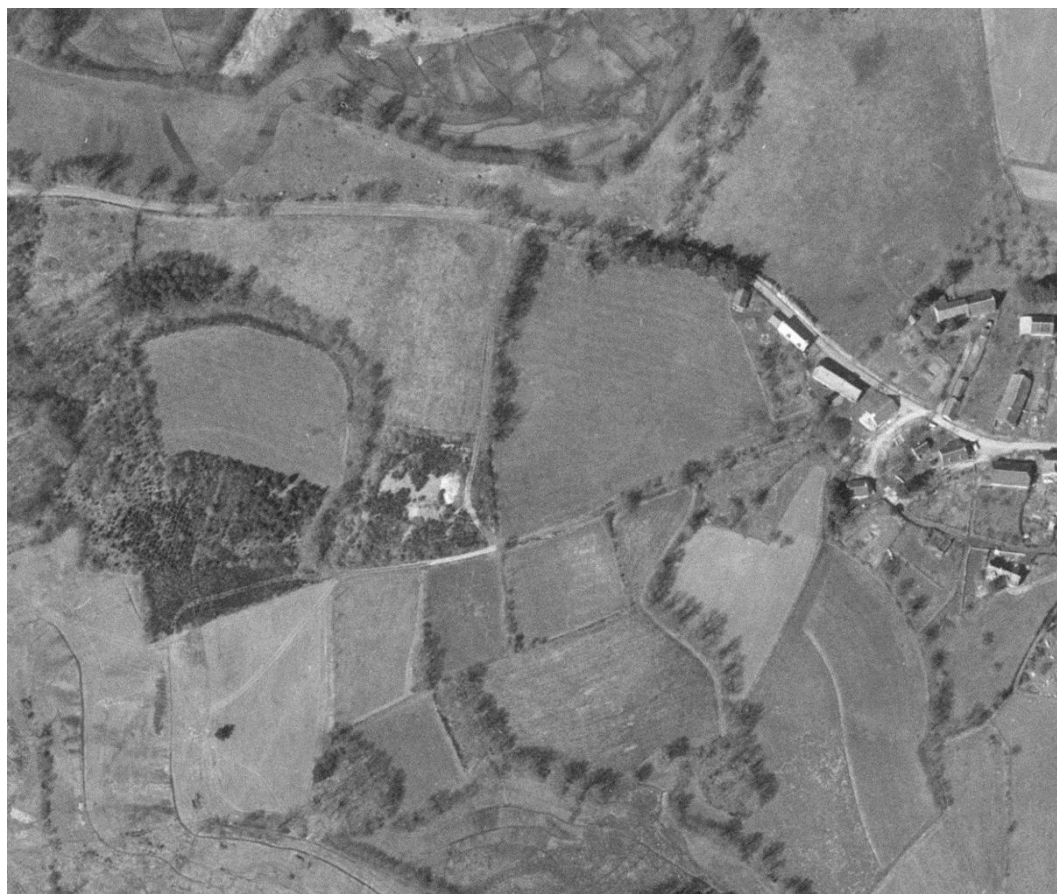
Figure 6 : Photographie aérienne du site de 1969 après travaux et démantèlement des installations de surface (source IGN)
