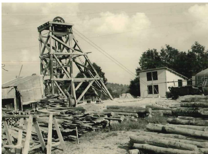
Figure 9 : Chevalement et local du treuil du site minier de la Vedrenne (1959), comparables à ceux autrefois présents sur le site de la Barrière
